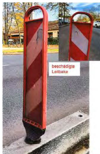
Kunststoff und Folie beschädigt und lose
