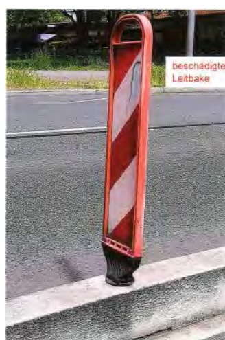
Kunststoff und Folie beschädigt und lose
