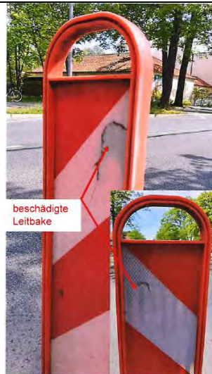
Folie und Kunststoff beschädigt
