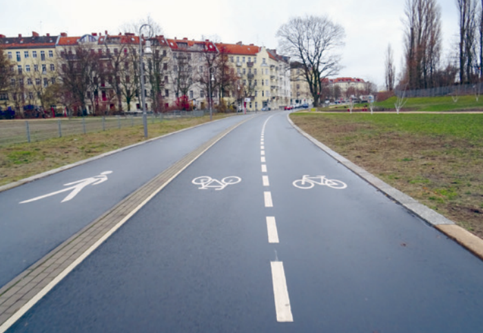
Torgauer Straße ©SHP Ingenieure
