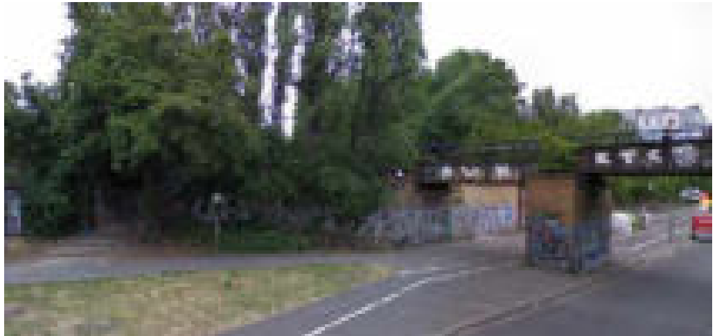
Abb. 168 Treppenabgang Görlitzer Park (© Google Maps)
