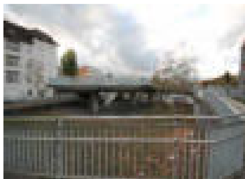
Abb. 84 Rampe an der Ostseite
