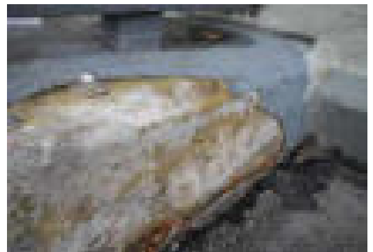
Abb. 127 Schadhafte Oberflächenschutzsystem am Gesims
