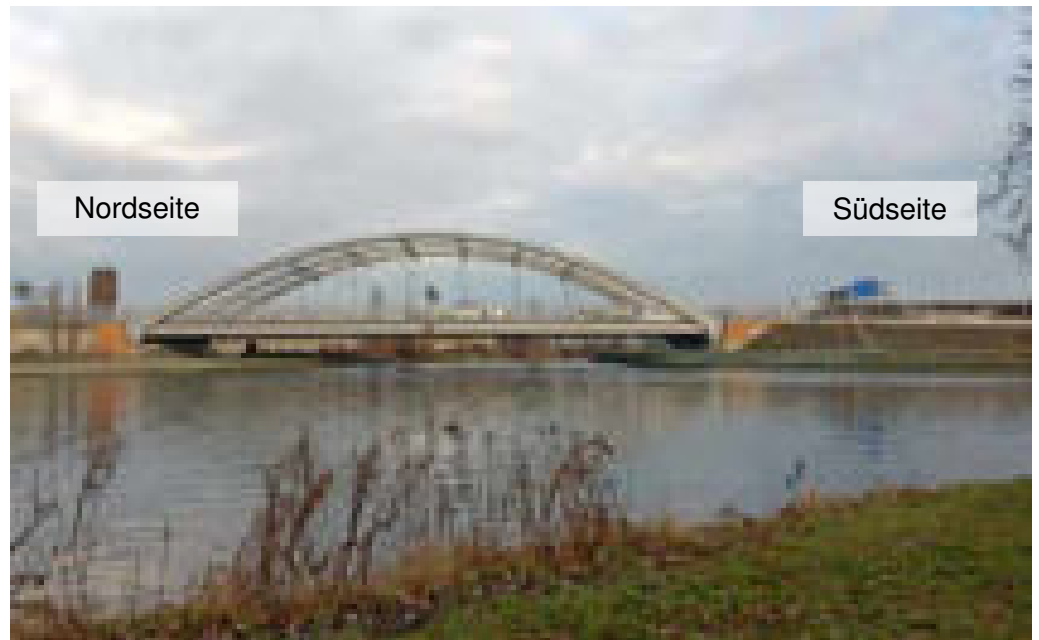
Abb. 65 Seitenansicht des Bestandsbauwerks
