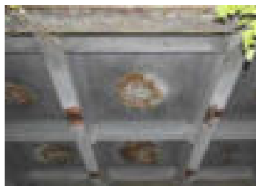
Abb. 164 Korrosionsschäden
