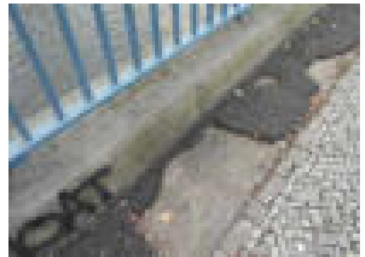
Abb. 133 Ausbesserung im Geh- und Radwegbereich
