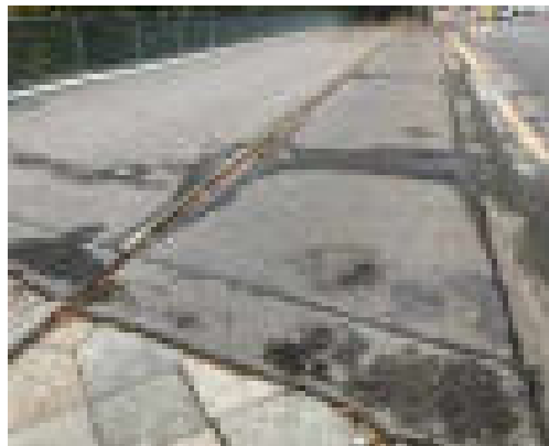
Abb. 52 Versatz zwischen Rad- und Gehweg
