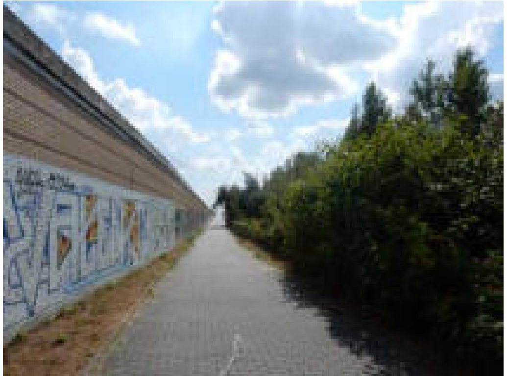
Abb. 10 Verbindungsrampe Neue Späthbrücke
