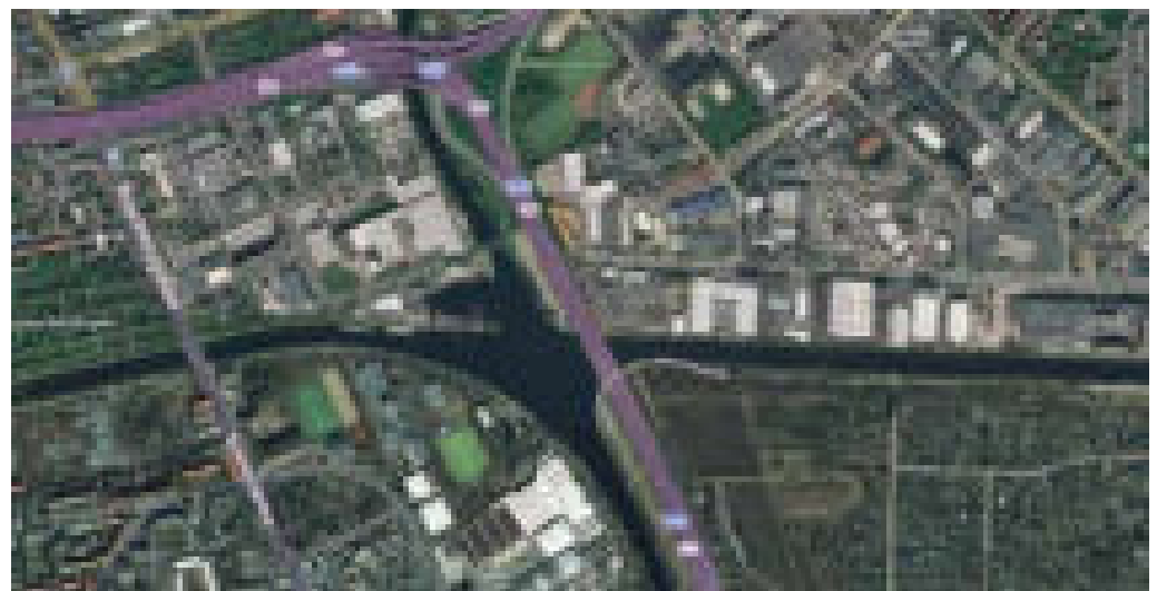
Abb. 64 Luftbild im Bereich des geplanten Brückenbauwerks ( www.bing.com )
