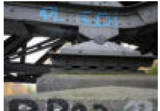
Abb. 48 Brückenlager
