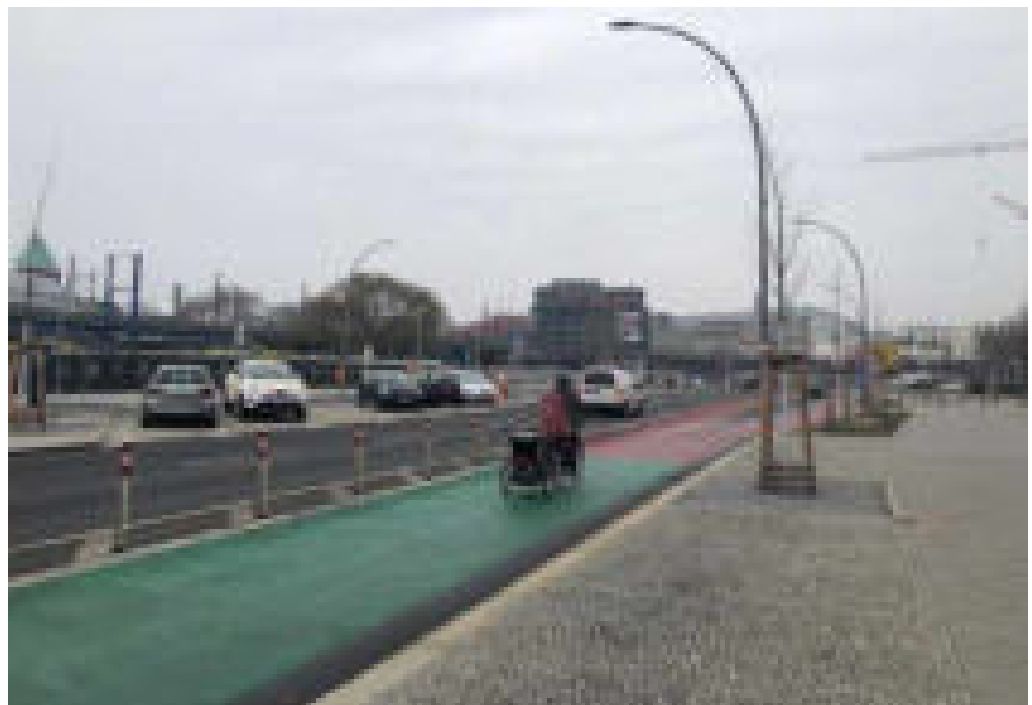
Abb. 181 Bereits umgesetzte Protected Bike Lane in Berlin
