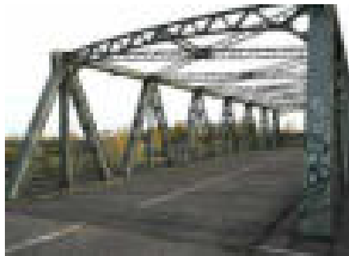
Abb. 21 Brückenfachwerk
