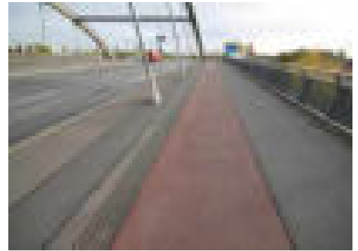
Abb. 31 Geh- und Radweg sowie Absturzsicherung
