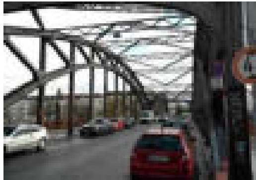
Abb. 115 Bogentragwerk und Fahrbahn
