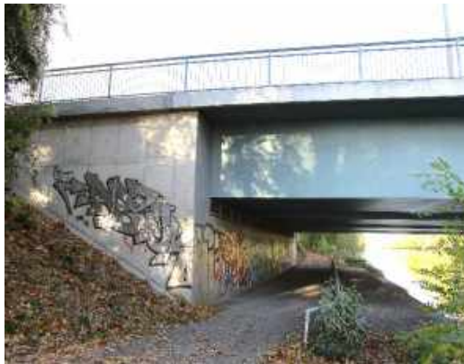
Abb. 47: Westl. Pfeiler und Seitenfeld
