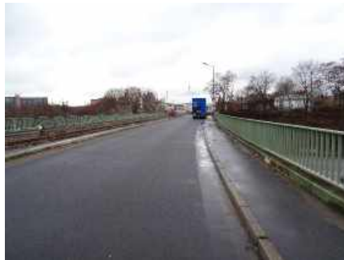
Abb. 27: Werdauer Weg – Autobahnbrücke
