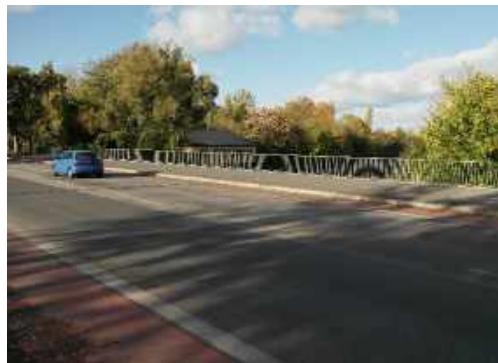
Abb. 38: Fahrbahn und Absturzsicherung
