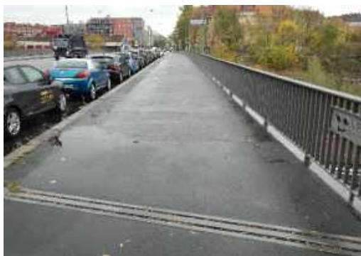
Abb. 115: Übergangskonstruktion im Geh- und Radwegbereich
