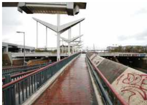
Abb. 108: Rampe zwischen Sachsendamm und Autobahn
