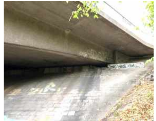
Abb. 88: Widerlagerbereich auf der Nordseite
