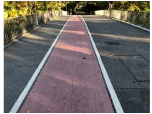
Abb. 61: Fahrbahn und Absturzsicherung
