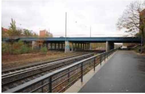
Abb. 111: Seitenansicht im Bereich des unterführten Radwegs
