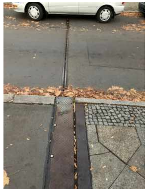
Abb. 84: Übergangskonstruktion
