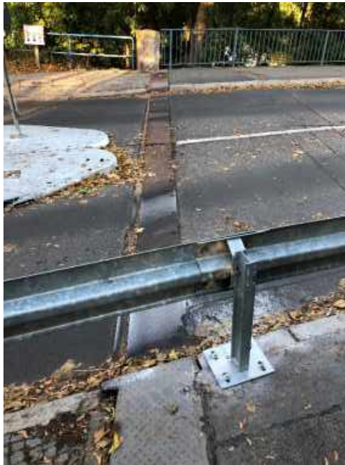
Abb. 56: Übergangskonstruktion
