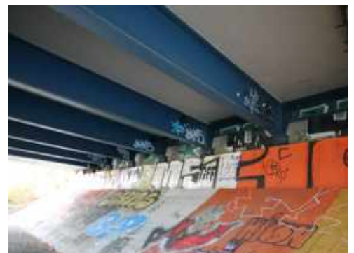
Abb. 116: Widerlager und Lager
