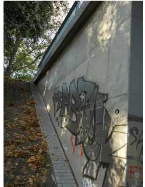
Abb. 46: Stahlbetonwand vor Seitenfeld
