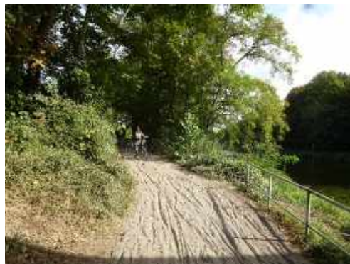
Abb. 10: Verbindungsrampe nördl. Emil-Schulz-Brücke
