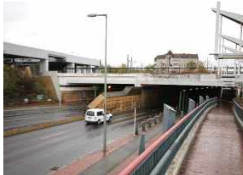
Abb. 104: Seitenansicht im Bereich des Sachsendamms
