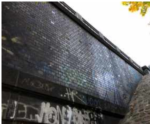
Abb. 77: Flügelwand des Widerlagers
