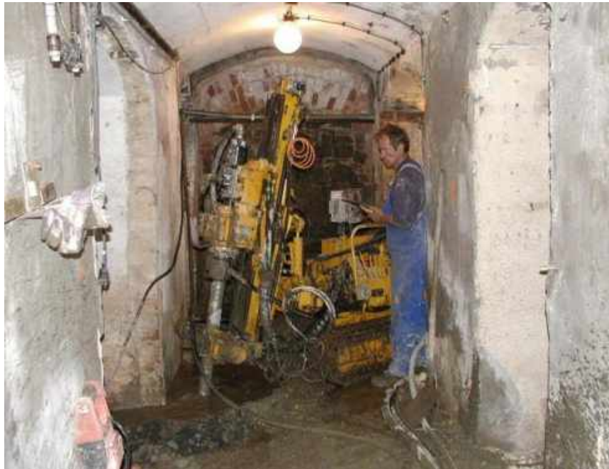
Abb. 70: Herstellen von HDI-Säulen in einem Gebäudekeller (© Implenia Spezialtiefbau GmbH, Düsenstrahlverfahren)
