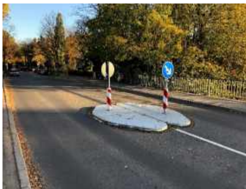
Abb. 58: Fahrbahn und Verkehrseinengung
