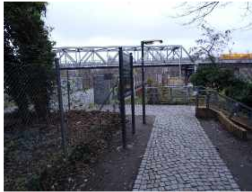
Abb. 129: Zuwegung der Brücke über den Landwehrkanal
