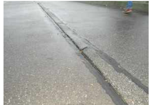
Abb. 100: Kantenstein zwischen Geh- und Radweg
