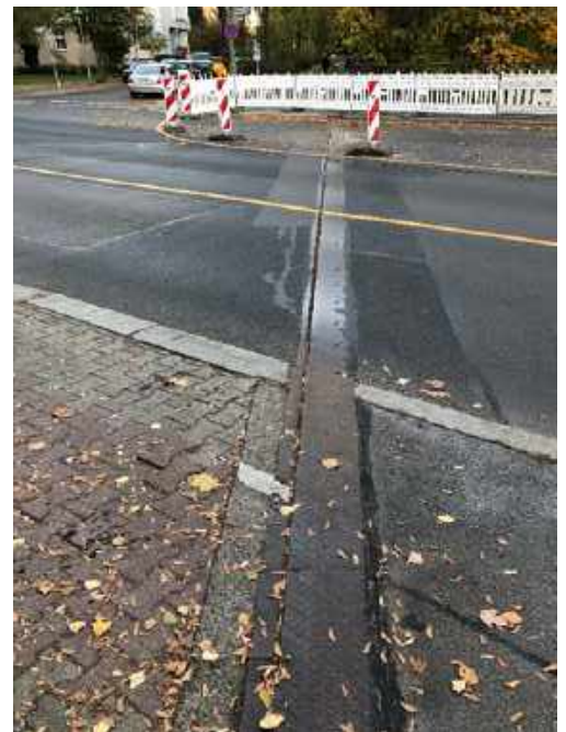
Abb. 90: Übergangskonstruktion
