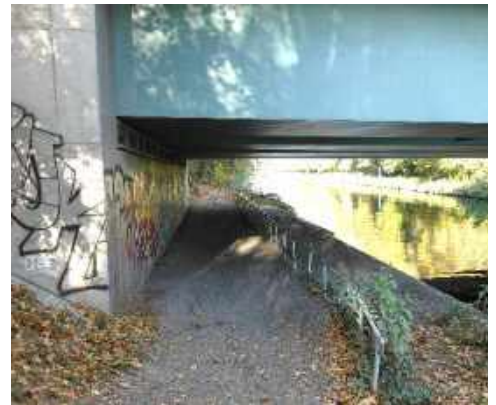
Abb. 48: Radweg vor dem westl. Pfeiler
