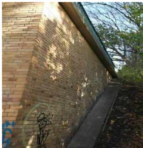
Abb. 40: Flügelwand
