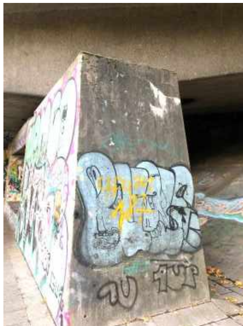
Abb. 89: Pfeiler auf der Nordseite
