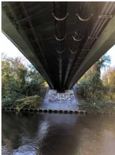
Abb. 62: Brückenunterseite (Blickrichtung auf westlichen Pfeiler)
