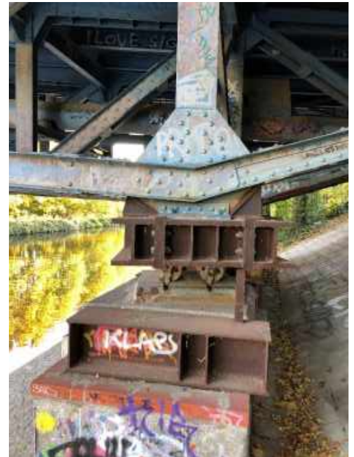
Abb. 57: Verstärktes Bauwerkslager
