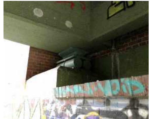
Abb. 82: Widerlagerbank und Brückenlager
