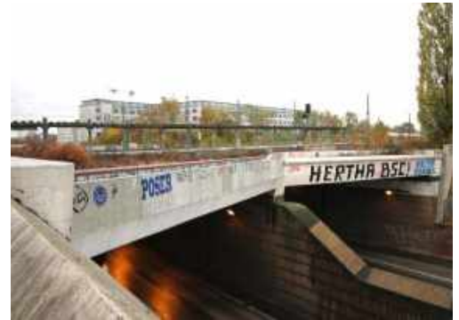
Abb. 105: Seitenansicht im Bereich der Autobahn
