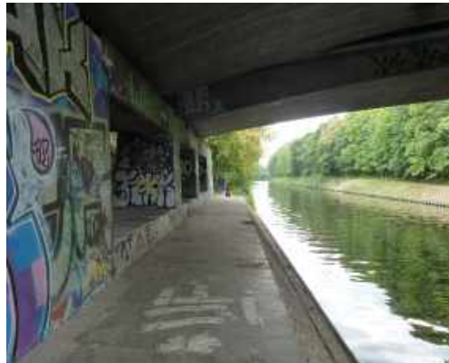
Abb. 87: Bereich zw. nördlichem Pfeiler und Teltowkanal
