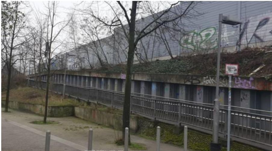
Abbildung 20: Fußgängerbrücke über Havel aus Blickrichtung Stabholzgarten
