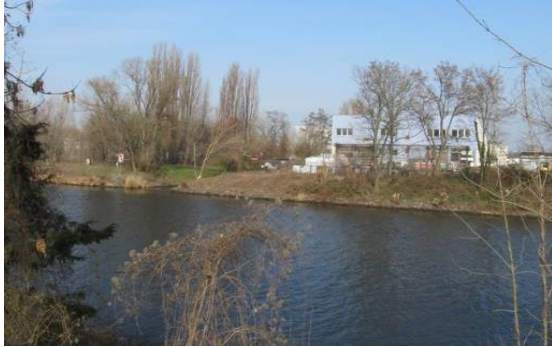
Abbildung 19: Bereich neue Spreequerung
