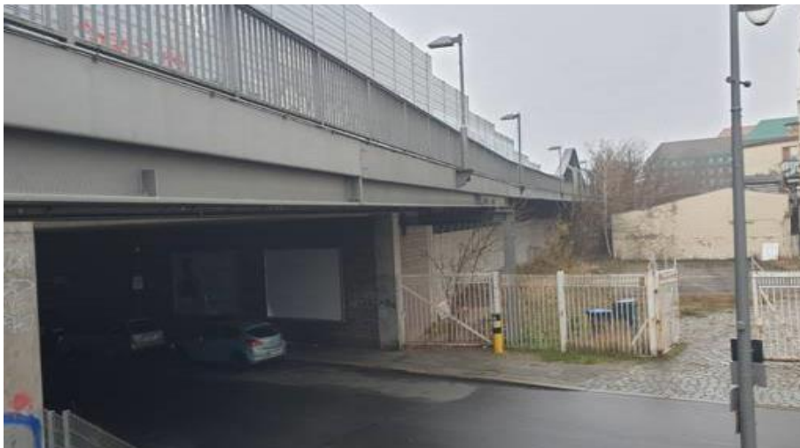
Abbildung 21: Fußgängerbrücke über Havel aus Blickrichtung Stresow
