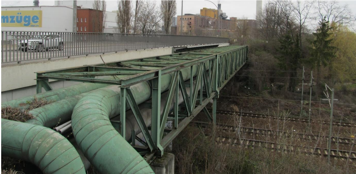
Abbildung 54: Leitungsbrücke parallel zur Wiesendammbrücke
