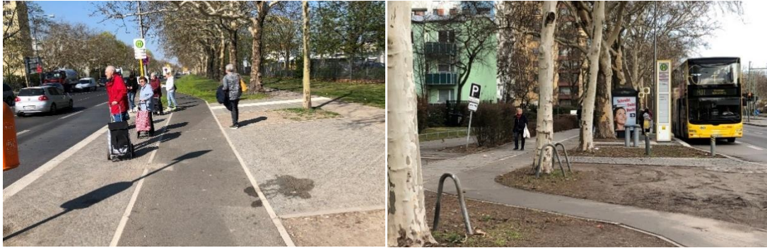
Abbildung 28: Radverkehrsführung durch und hinter den Haltestellenbereich in Berlin-Spandau (Heerstraße) 23
