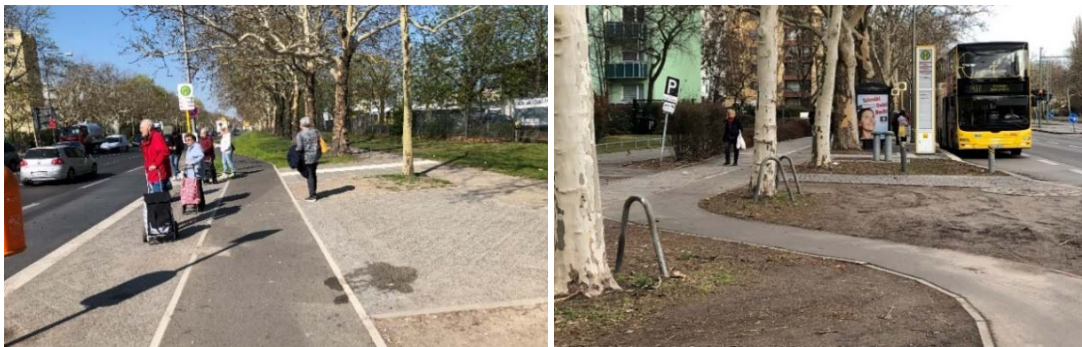
Abbildung 56: Radverkehrsführung durch und hinter den Haltestellenbereich in Berlin-Spandau (Heerstraße) 28
