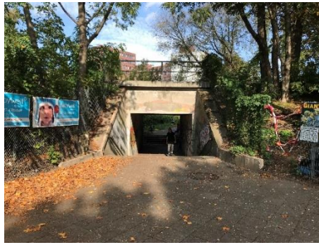
Abbildung 41: Unterführung Soltauer Str./Otisstraße
