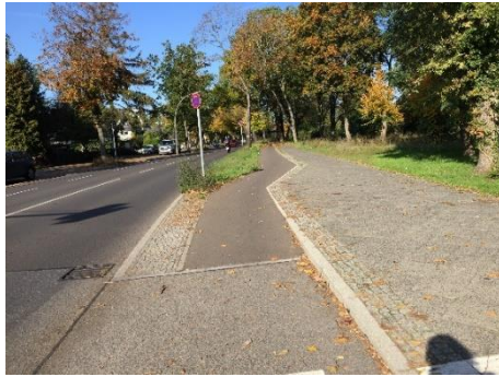
Abbildung 16: Ruppiner Chaussee Höhe Kiefheider Weg
