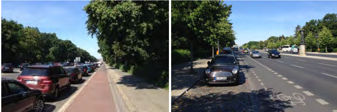
Abbildung 30: Straße des 17. Juni westl. Großer Stern Abbildung 30: Straße des 17. Juni östl. Großer Stern (3)
