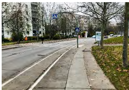
Abbildung 94: Gothaer Str. (Alte Hellersdorfer Str.)
