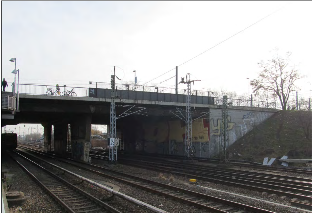
Abbildung 207: Allee der Kosmonauten, Brücken über Bahnanlagen – BW 6a, 6c
