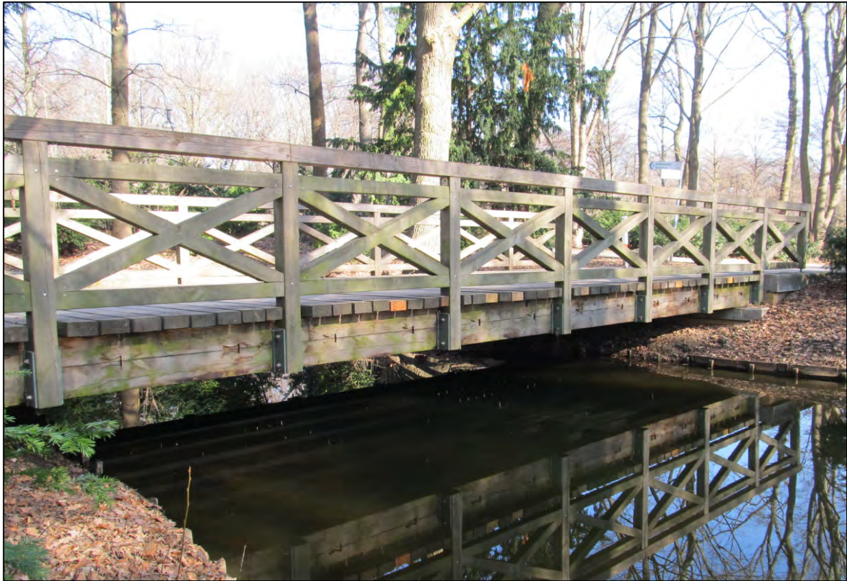
Abbildung 211: Bremer Weg, Holzbrücke 2
