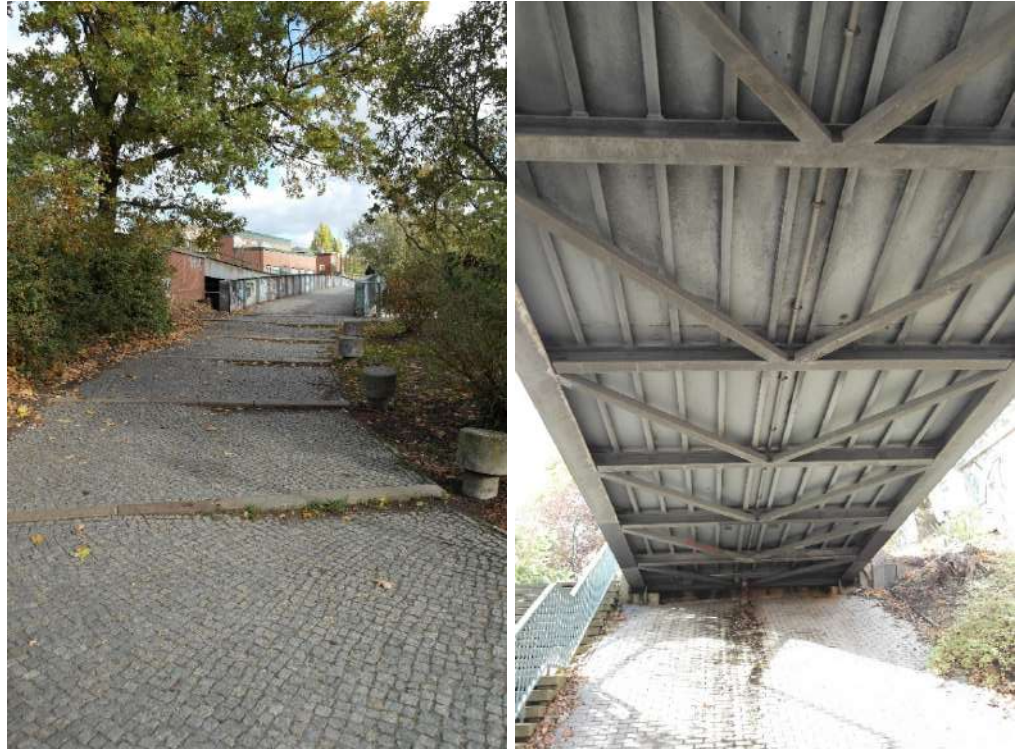
Abb. 12 Rampen mit Stufen (links), Brückenunterseite (rechts)
