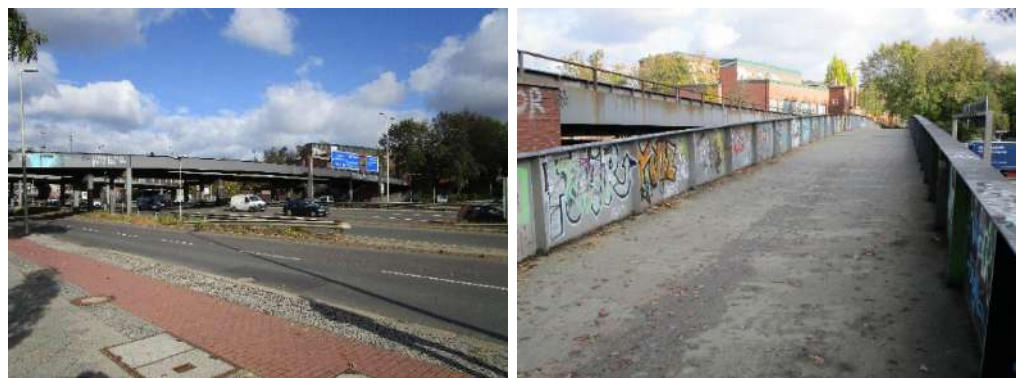
Abb. 11 Seitenansicht (links), Fahrbahn und Absturzsicherung (rechts)
