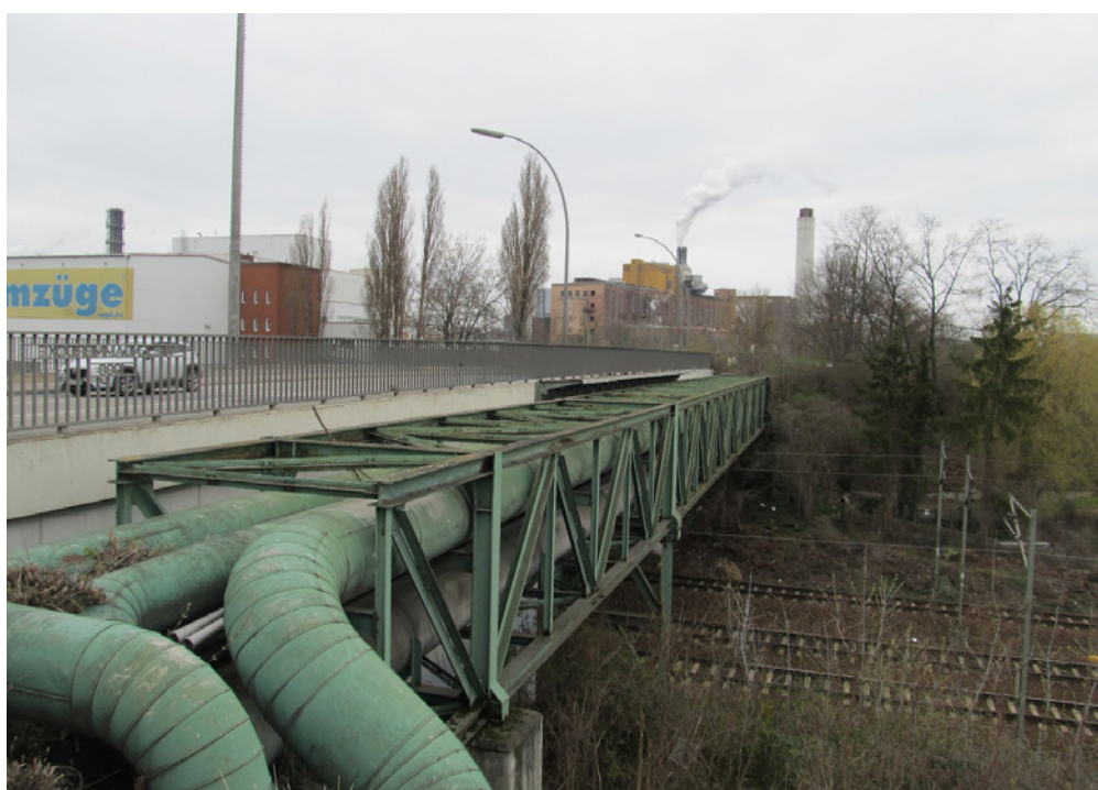
Abbildung 11: Leitungsbrücke parallel zur Wiesendammbrücke
