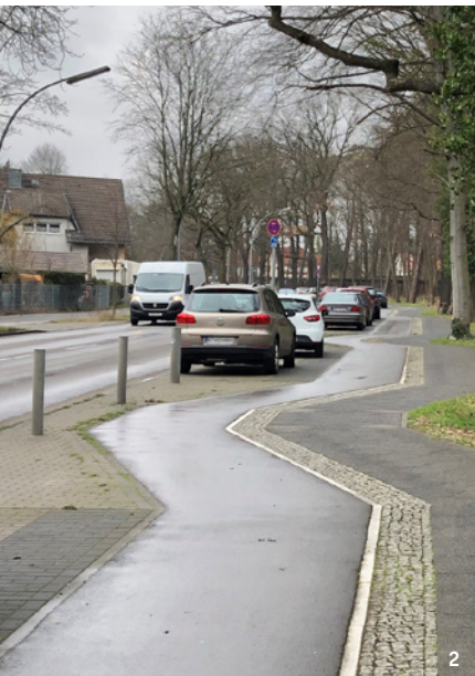
Abbildung 2 (links): Radverkehrsinfrastruktur auf der Ruppiner Chaussee im Ist-Zustand, mit häufigem Versatz
