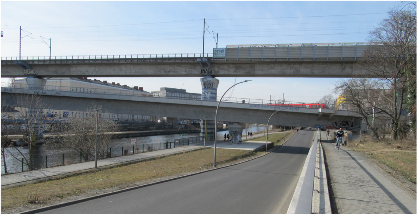
Abbildung 23/24 Nordufer in Fahrtrichtung stadtauswärts im Bereich der neuen Querung mit der S-Bahnlinie 21 (ETC/EIBS/Rambøll/ Design-Gruppe)
