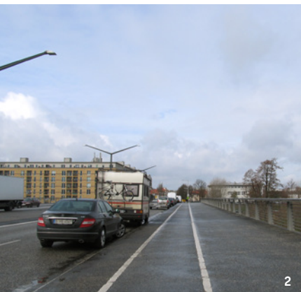
Abbildung 2: Wasserstadtbrücke in Fahrtrichtung stadtauswärts mit Radweg auf Gehwegniveau
