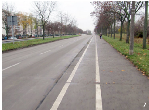
Abbildung 6: Allee der Kosmonauten im Ist-Zustand mit zu gering bemessener Radverkehrsinfrastruktur
